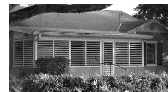
Metal louver windows
